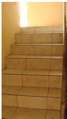
Figura 2.30: Gradas con baldosa en su superficie
