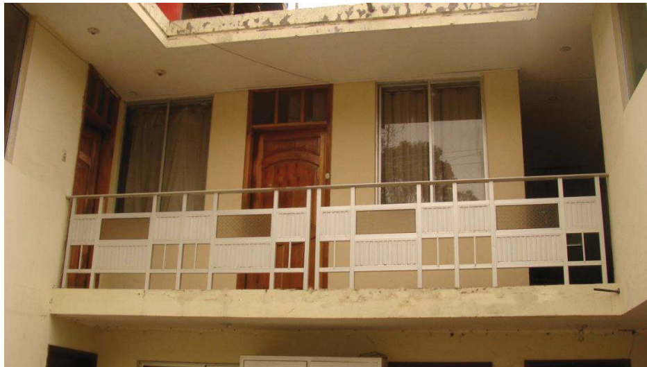
Figura 2.33: Pasillos en Voladizo
