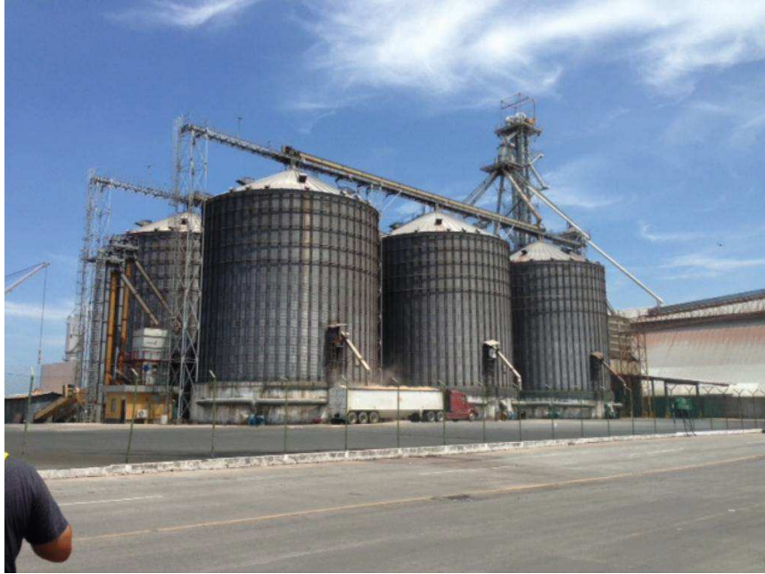
Figura 31. Silos (Almacenamiento de granos)
