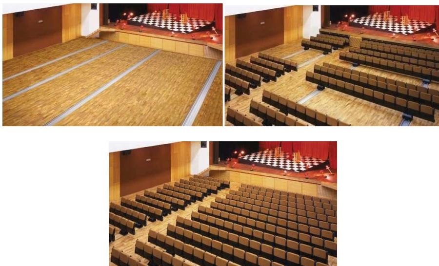
Figura 11.4. Sistema de suelos móviles Mutaflex propiedad de la empresa Figueras International. (1) Sala despejada, (2) ingreso de butacas a la platea (3) filas de butacas armadas,
