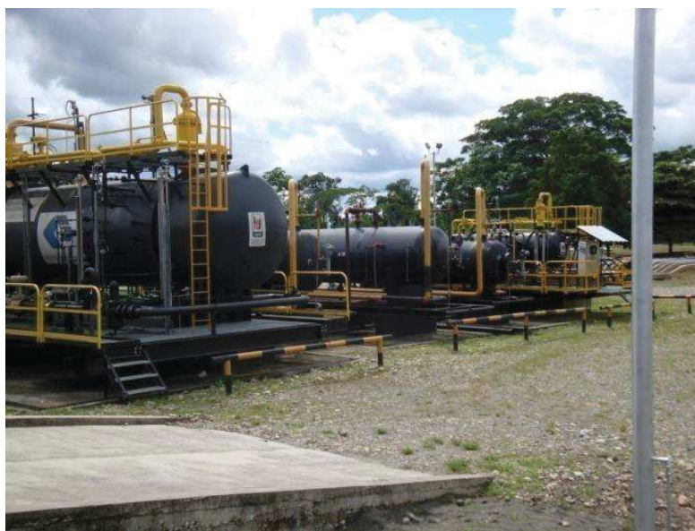
Figura 24. Separadores de prueba y producción de la Estación Shushuqui.
