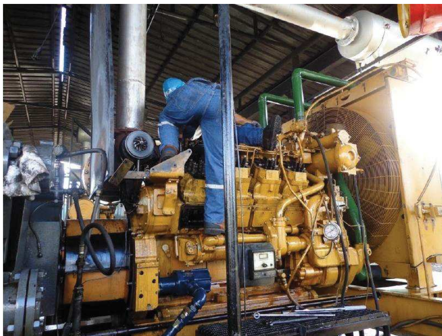
Figura 34. Mantenimiento correctivo de la unidad principal de bombeo.
