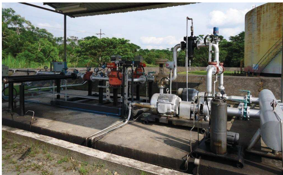
Figura 25. Unidad Lact de la Estación Shushuqui
