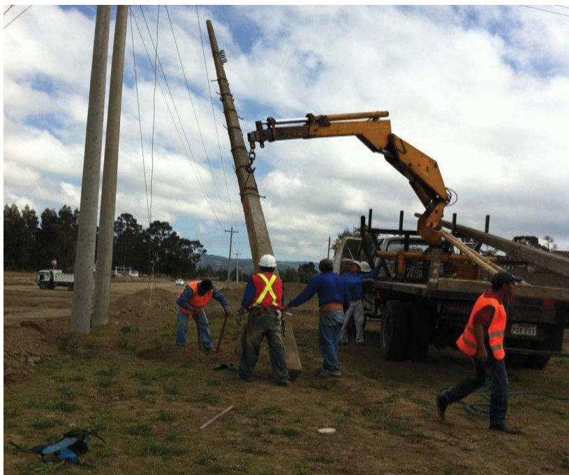
Figura 28. Traslado de poste con ayuda de la grúa.
