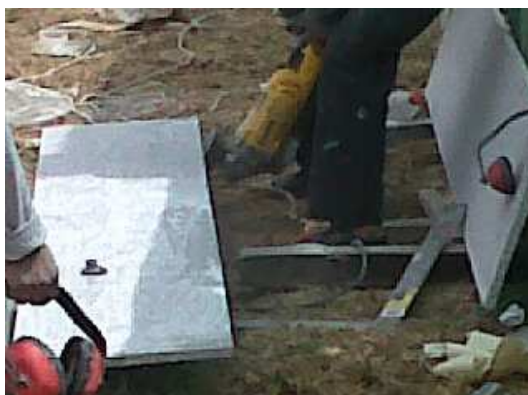
Figura 17. Utilización de la amoladora.
