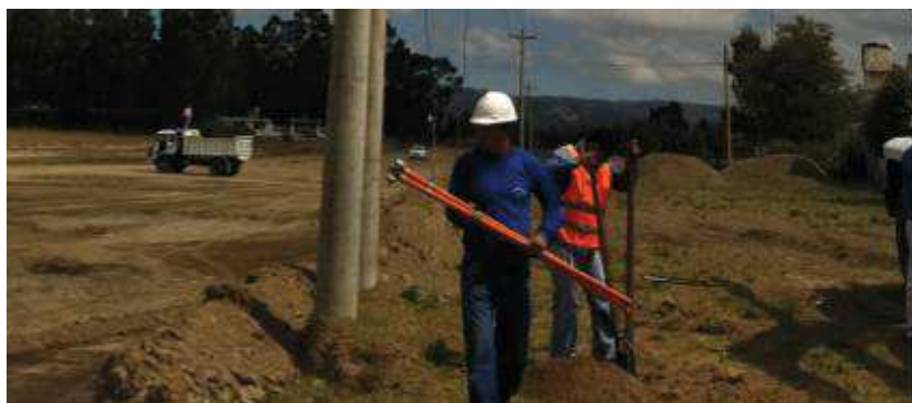
Figura 30. Excavación de hoyos para la ubicación del poste. Adaptado de: La Organización Ecapro, 2011.
