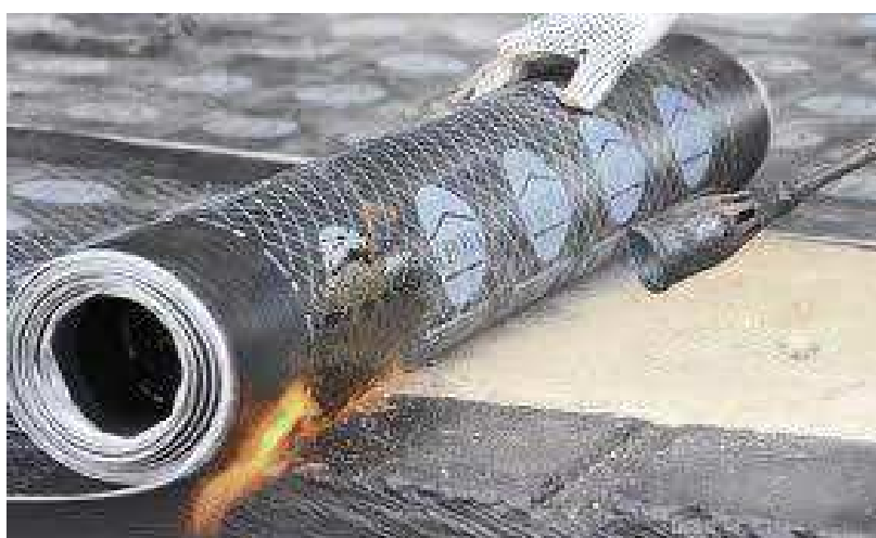
Figura 38. Colocación de chova material impermeable. Adaptado de: La Organización Ecapro, 2011.
