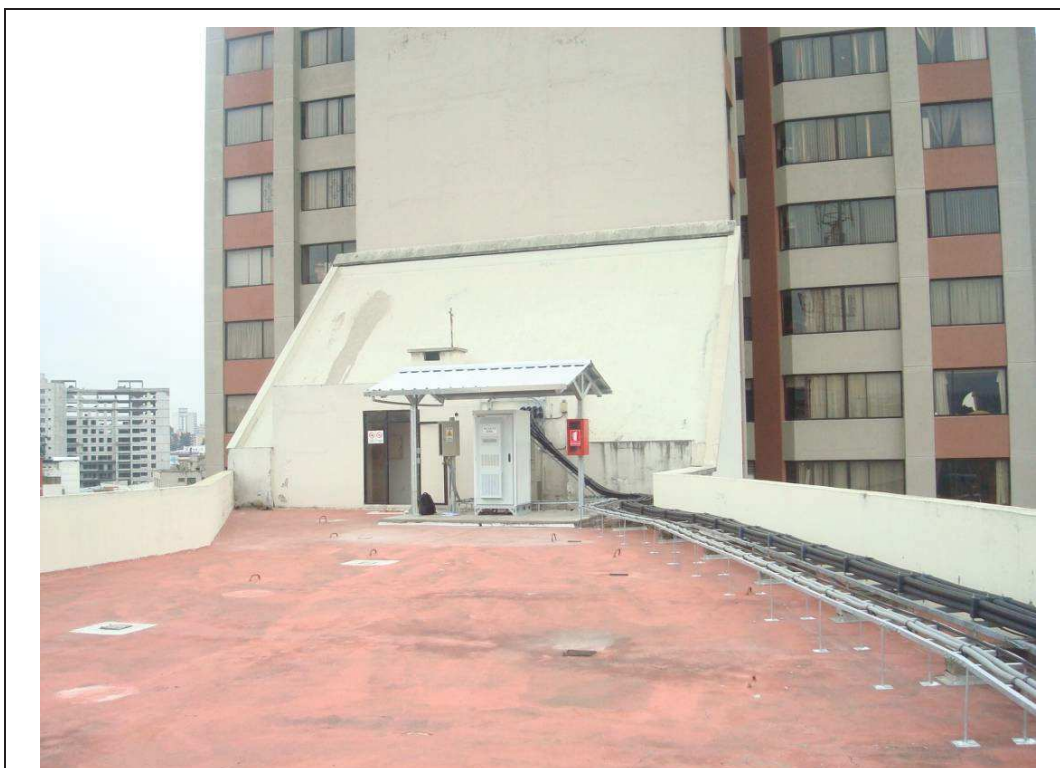
Figura 13. Se observa la losa, la estructura metálica instalada y el cable que va en la parte superior de la escalerilla.
