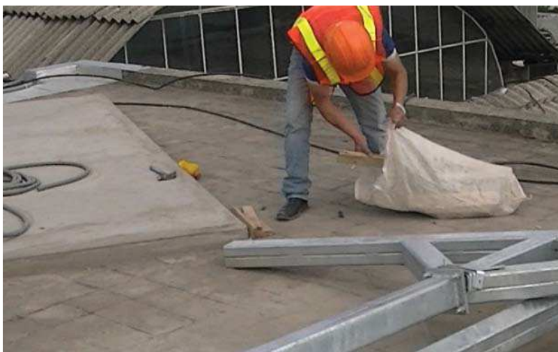
Figura 20. Almacenamiento de materiales. Adaptado de: La Organización Ecapro, 2011.
