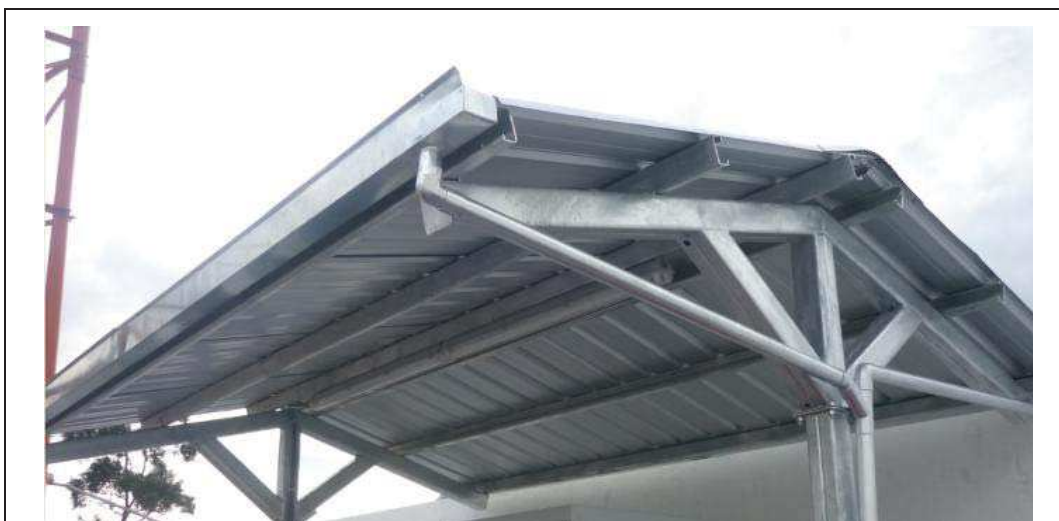
Figura 9. Colocación de la estructura metálica: se unen las piezas por medio de placas y pernos.
