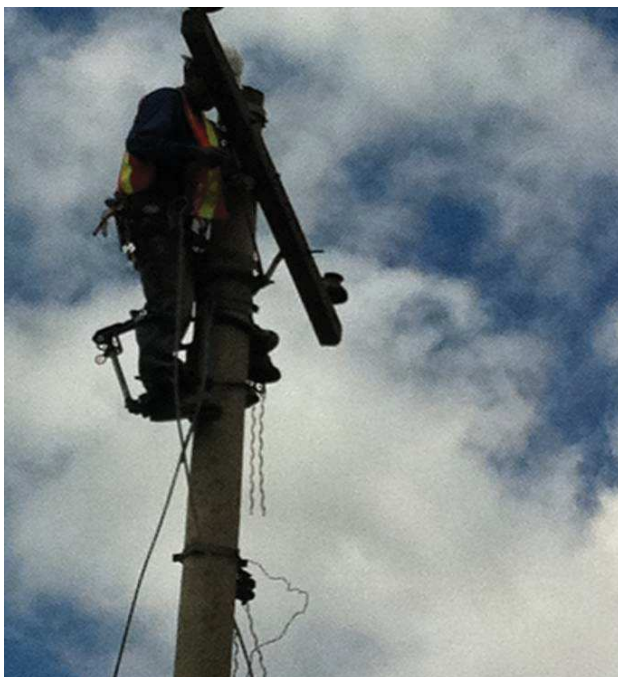
Figura 29. Instalación de redes eléctricas. Adaptado de: La Organización Ecapro, 2011.
