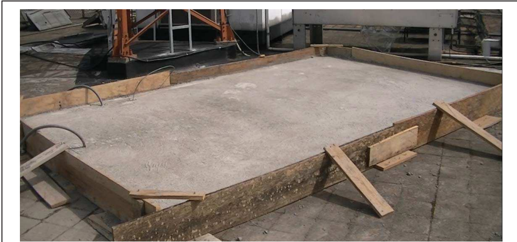
Figura 5. Se observa la losa de hormigón cubierta por el encofrado el mismo que deberá ser retirado en 24 horas.
