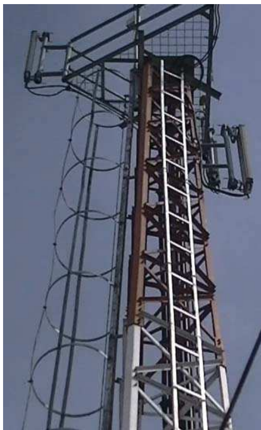
Figura 39. Instalación de escalerillas verticales en una torre Adaptado de: La Organización Ecapro, 2011.
