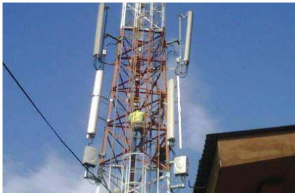
Figura 18. Instalación de escalerillas.
