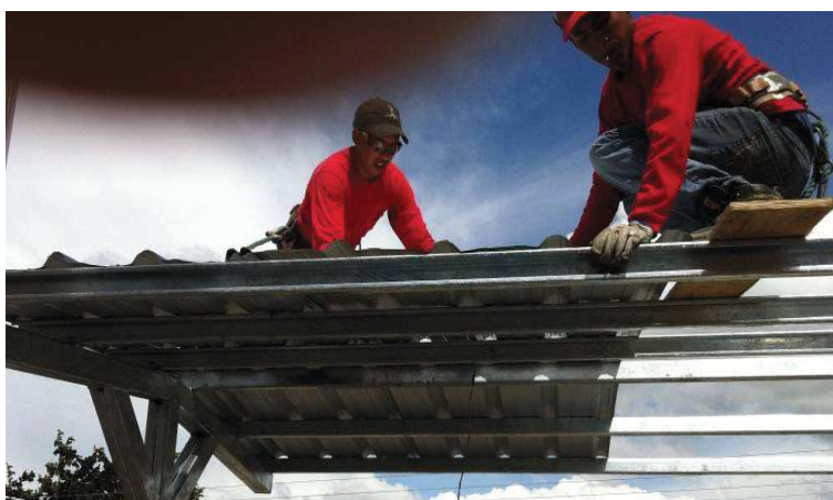
Figura 25. Instalación de tubos en la estructura metálica. Adaptado de: La Organización Ecapro, 2011.
