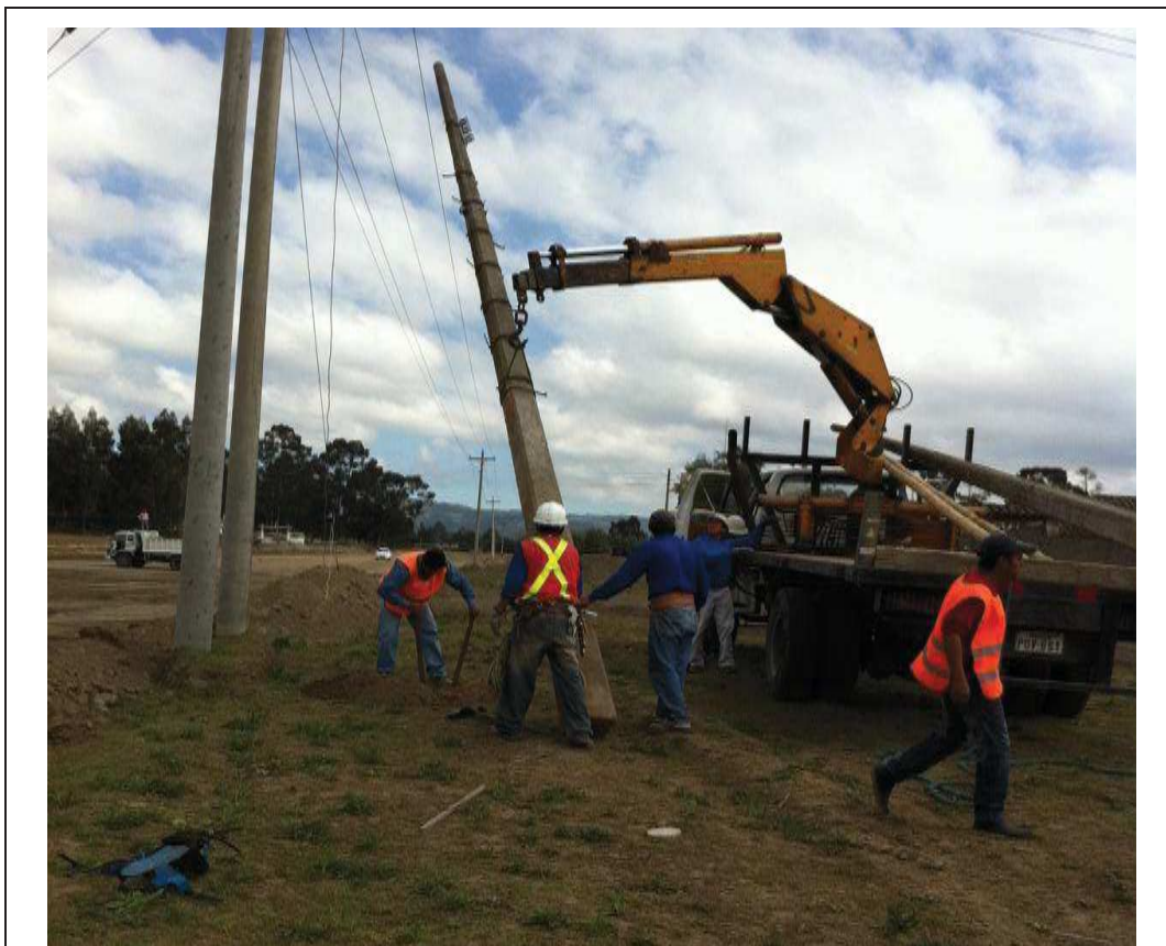
Figura 15. Se observan el movimiento del poste para su posterior remodelación. Adaptado de: La Organización Ecapro, 2011.
