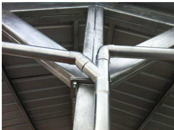
Figura 23. Instalación de canales de agua en la estructura metálica. Adaptado de: La Organización Ecapro, 2011.
