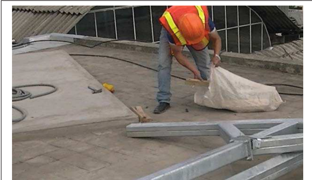
Figura 3. Limpieza del sitio de trabajo en la terraza del Edificio el Doral de Corporación Nacional de Telecomunicaciones.
