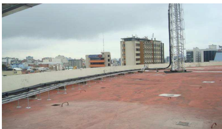
Figura 22. Colocación del cable sobre las escalerillas que sirven de soporte. Adaptado de: La Organización Ecapro, 2011.
