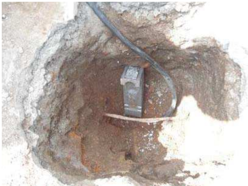
Figura 37. Soldadura por medio de pólvora. Adaptado de: La Organización Ecapro, 2011.
