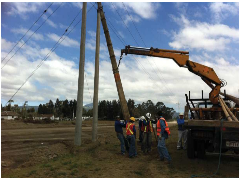
Figura 26. Levantamiento de postes en remodelación. Adaptado de: La Organización Ecapro, 2011.
