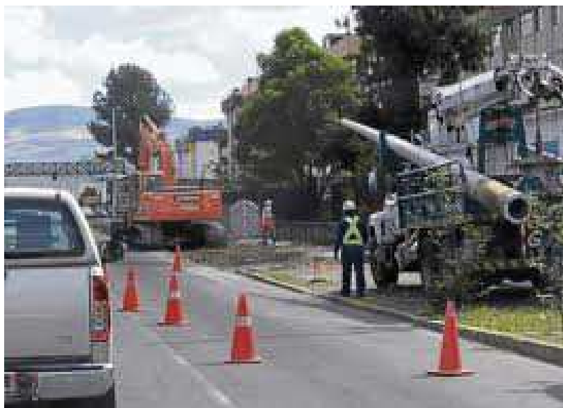
Figura 43. Señalización del área de trabajo
