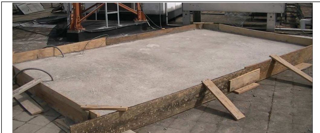
Figura 40. Construcción de losa de Hormigón
