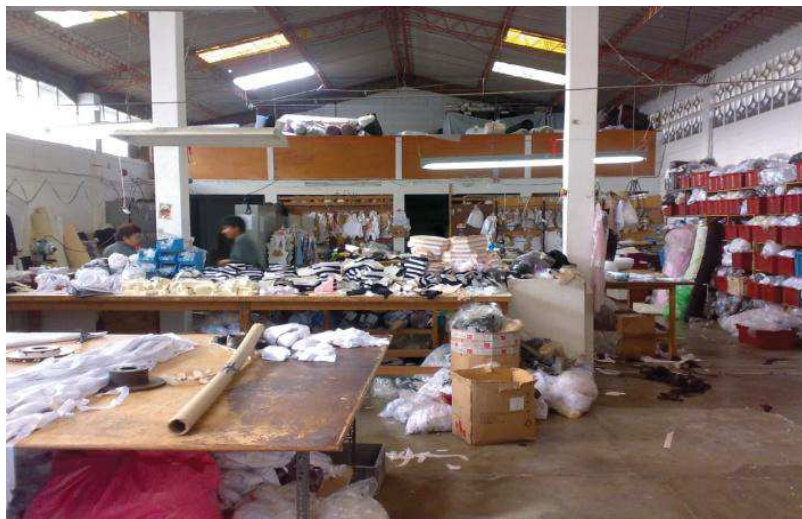
Figura No. 3.2 “Falta de Equipo de Detección de Incendios”
