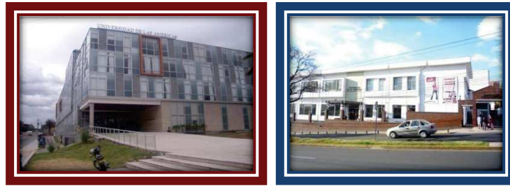
FIGURA 4.4 Fachada de la Sede Norte y Sede Colón
