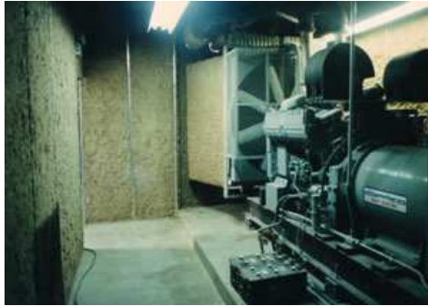
Foto 3-7. Área de cuarto de máquinas.
