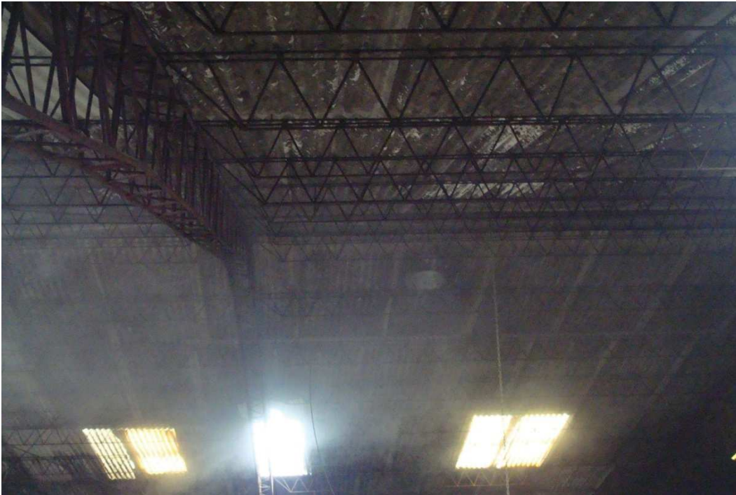
Techo de la planta antigua
