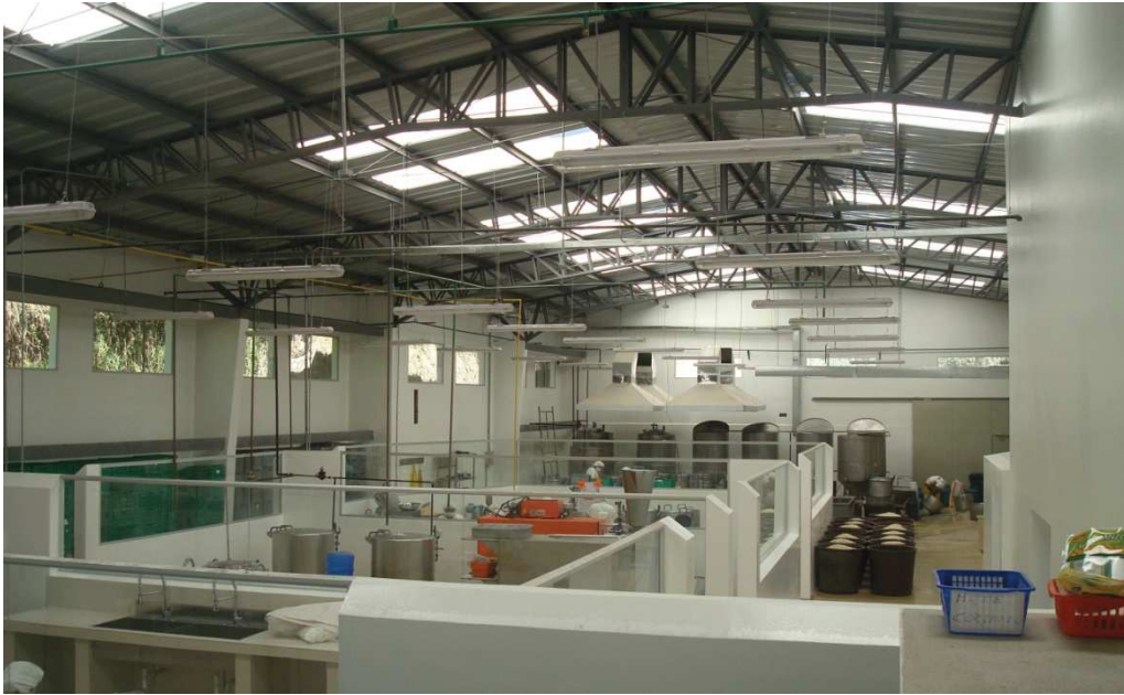
Vista general de la planta
