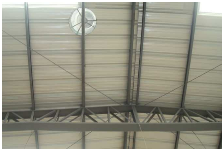
Techo de planta
