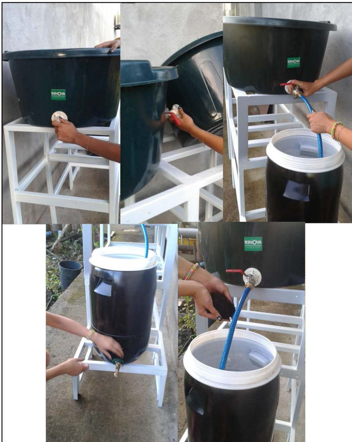
Figura 27. Construcción de la planta piloto
