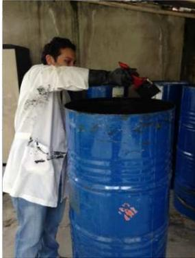
Aplicación de brea líquida dentro de los tanques.
