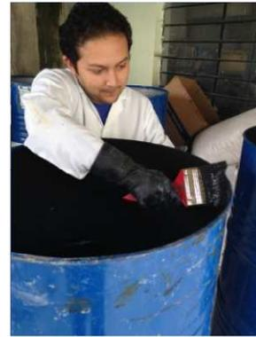
Aplicación de brea líquida dentro de los tanques.
