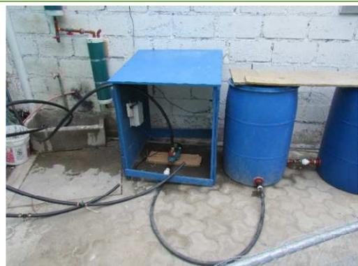
Conexiones de la bomba desde los tanques de almacenamiento.
