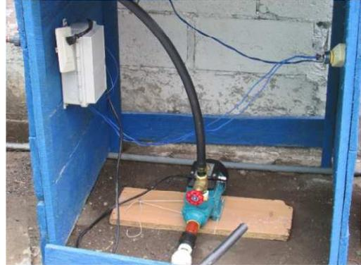
Instalación de la bomba junto con el *timer*.
