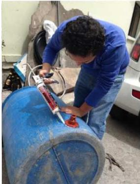
Adaptación y conexión de los tanques para que se acomplan a las mangueras y al sistema de riego del agua residual.
