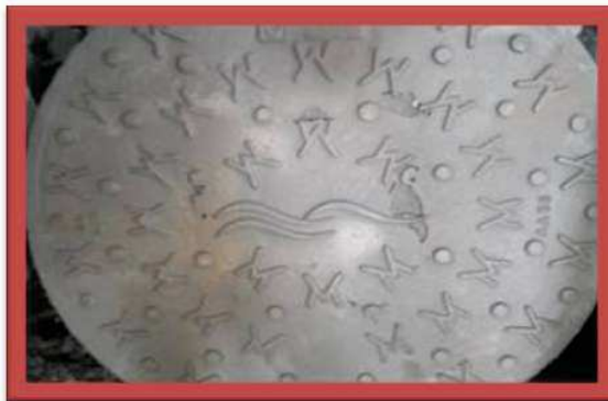
Ilustración 3.11: Pieza con desprendimiento de arena
