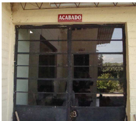
Figura 37. Área de acabado de la fábrica.
