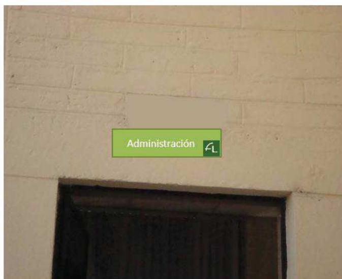
Figura 54. Montaje del rótulo de la Administración colocado en la puerta de las oficinas,
