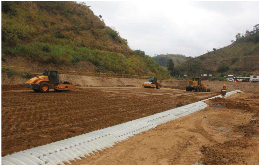
Figura 14, Avances de los trabajos en el PPMCH.
