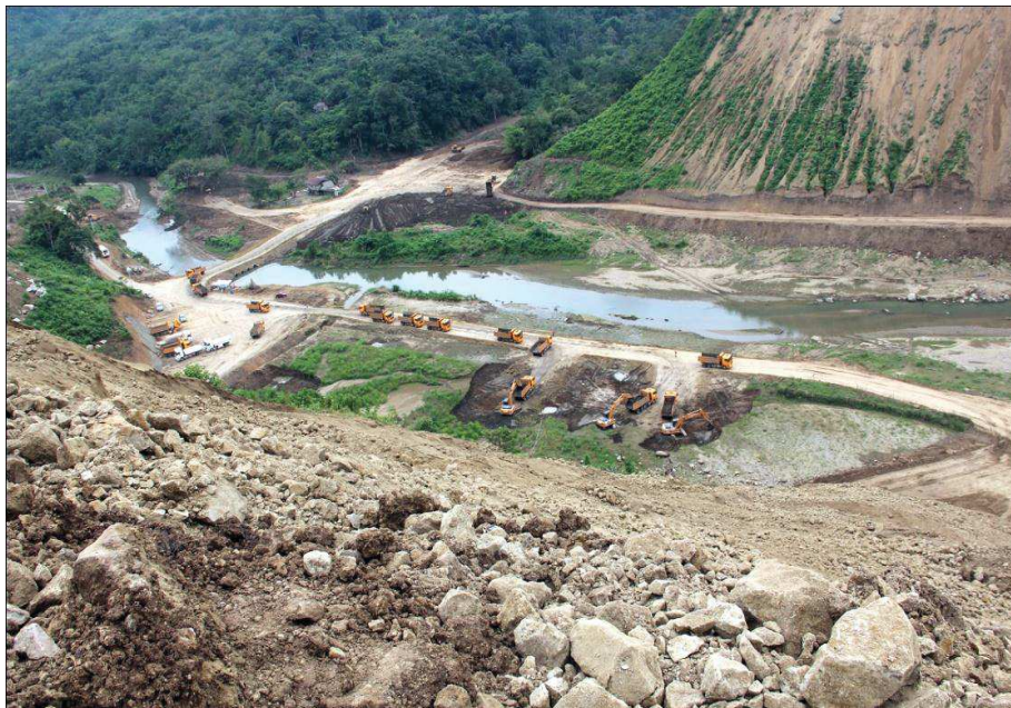
Figura 15. Avances en los trabajos del PPMCH.
