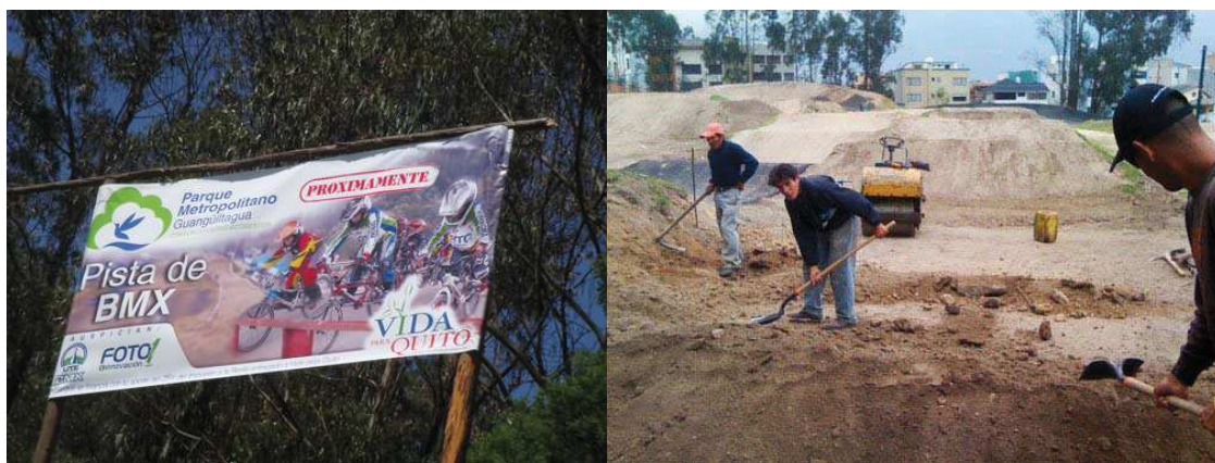
Figura 8. Trabajos en la pista de BMX
