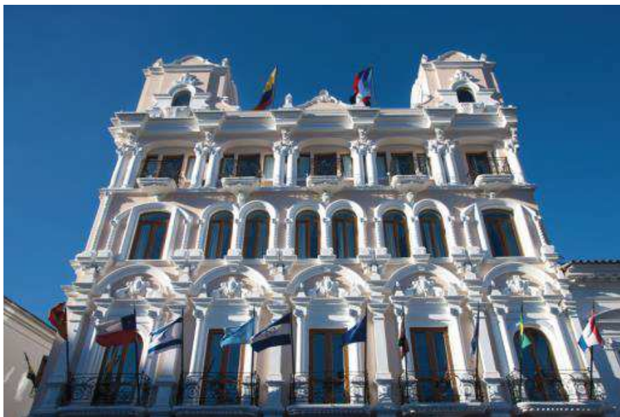
Figura 30. Fachada vista desde la Plaza de la Independencia Tomado de: Plaza Grande, 2014.
