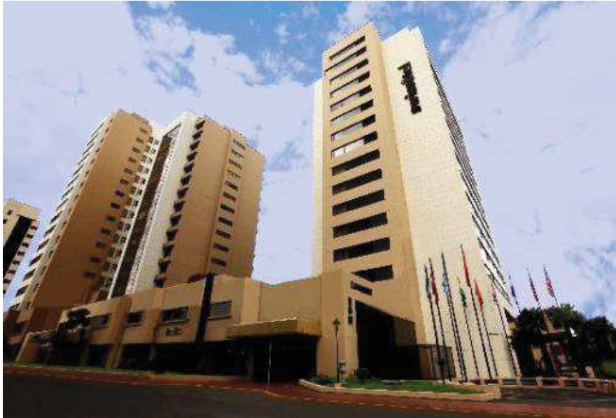
Figura 24. Fachada del hotel Tomado de: Swissotel, 2014.
