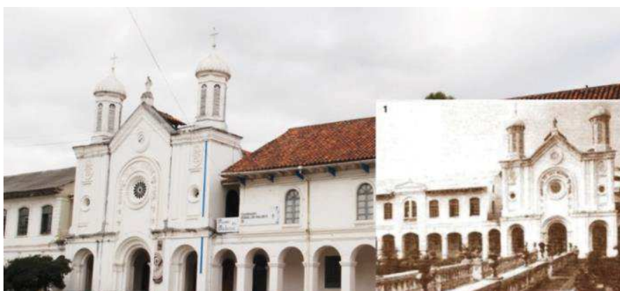
Figura 5. Actual y antigua de la fachada del Hospital.
