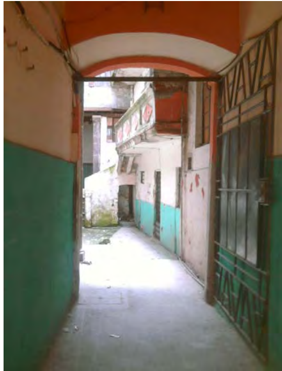
Fotografía 14.11 Vista desde la entrada de la edificación
