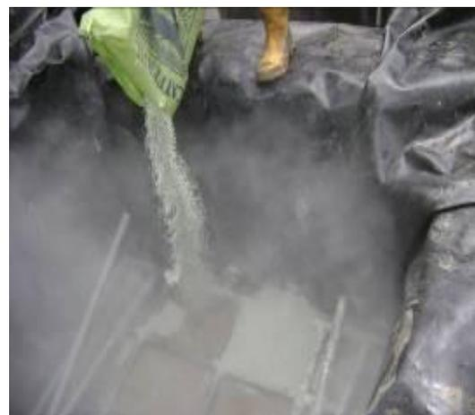
**Foto 4.15.** Colocación de una capa de zeolita y carbón activado.
