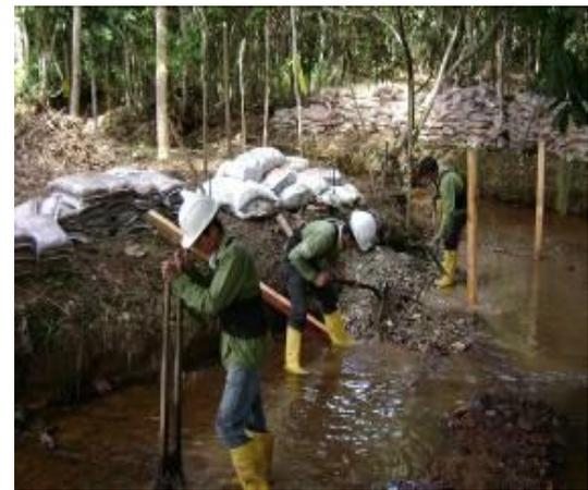
**Foto 4.5.** Realización de agujeros para la instalación de postes de madera.
