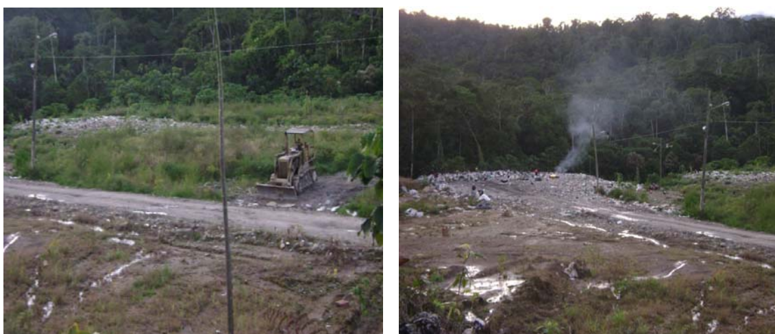
FOTOGRAFIA 3.39 y 3.40. Vista del relleno sanitario del cantón Tena.
