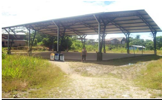
FOTOGRAFIA 119. Contenedores en cancha cubierta de Tio Yacu.
