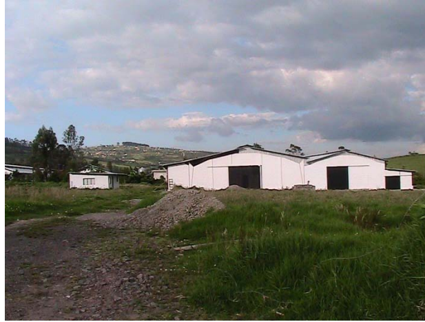
Foto N. 10 Empresa en construcción atrás de Rizzoknit
