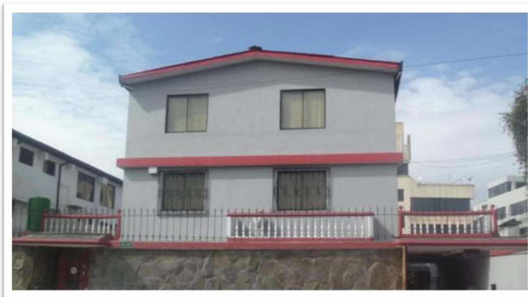
Figura 4. Imagen de la vista externa de la residencia.
