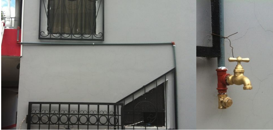
Figura 35. Unión de la tubería hacia las salientes de agua.
