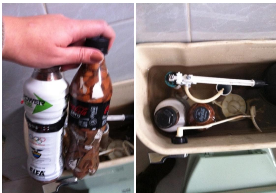
Figura 28. Introducción de botellas para reducción de consumo de agua en cada descarga.
