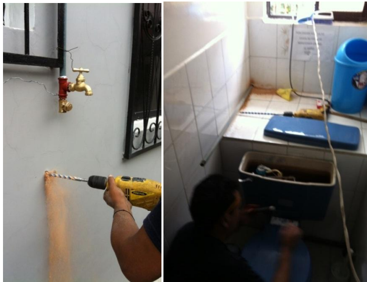
Figura 36. Perforación de la pared.
