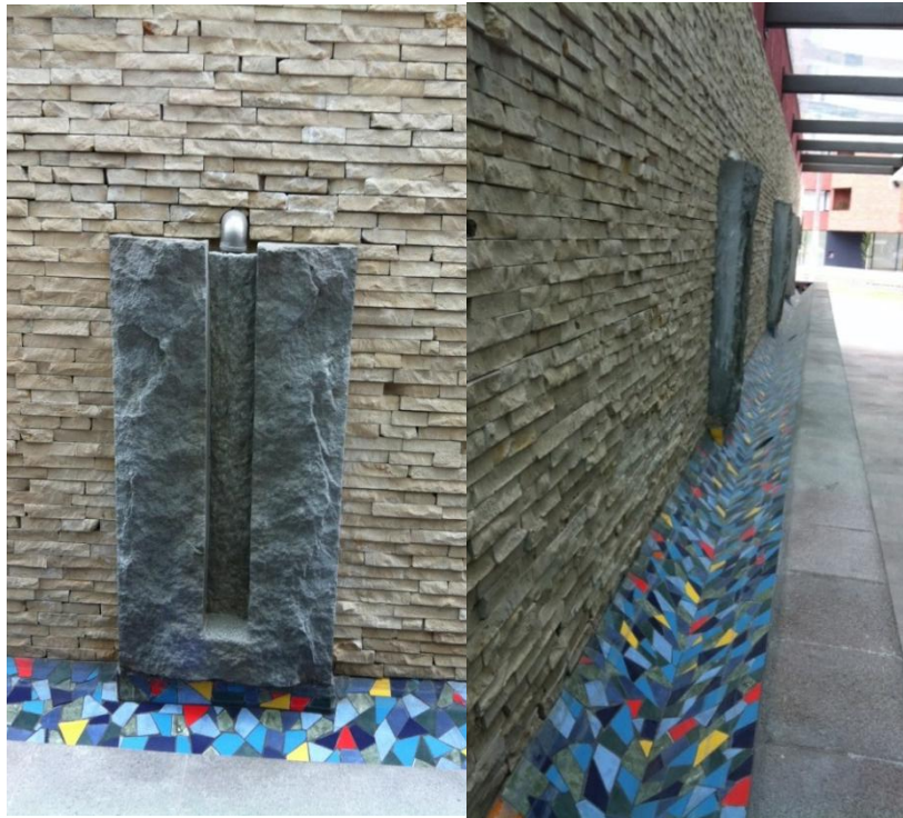
Figura 21. Elemento decorativo con agua recolectada de lluvia y luces inactivo, edificio Keybuilding.
