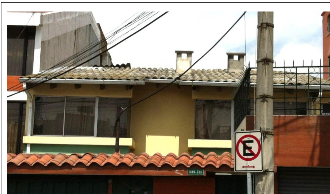
Figura 18. Residencia con sistema de recolección de agua de lluvia para reducción de agua potable.
