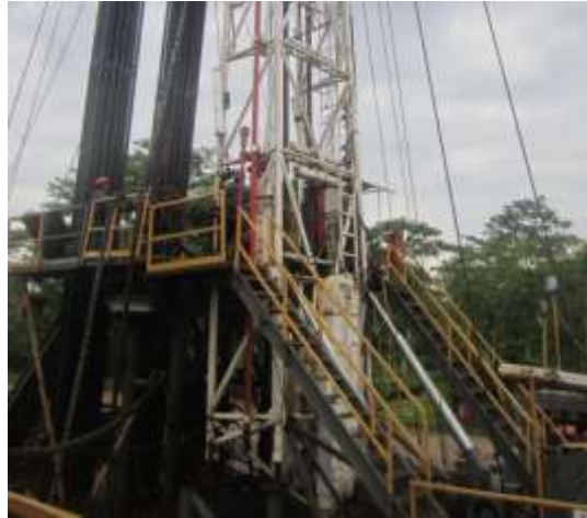
Figura 7. Subestructura 1 de la torre de reacondicionamiento de pozos.
