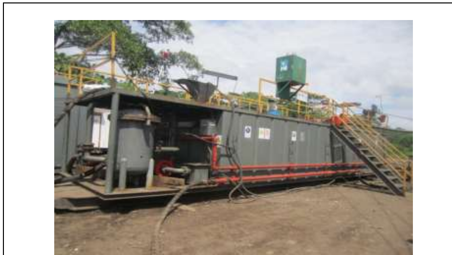
Figura 19. Tanque de lodos, donde se almacenan los lodos.
