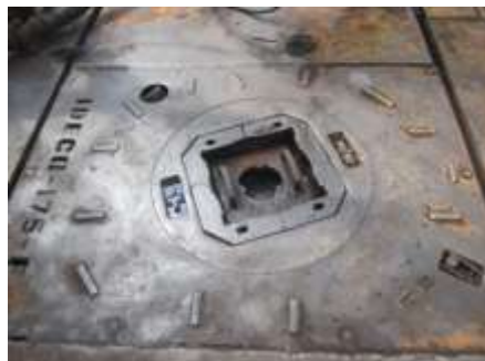
Figura 14. Mesa rotaria ubicado en la subestructura uno del taladro de reacondicionamiento de pozos.
