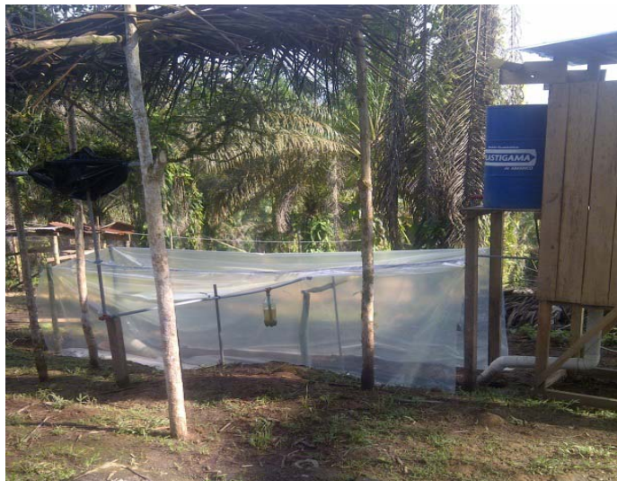
Figura 33. Techado del biodigestor
