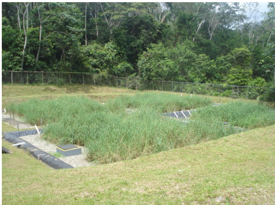
Figura 2. Instalaciones del campamento actual en el campamento AMO1
