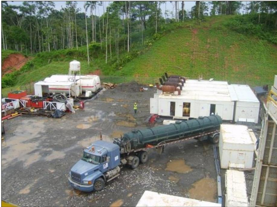
*Figura 15.* Área de generadores y tanques de combustible diesel
