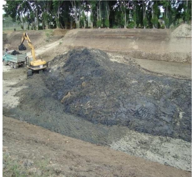
Construcción de las camas experimentales para la Biorremediación en la carpintería de REE.
