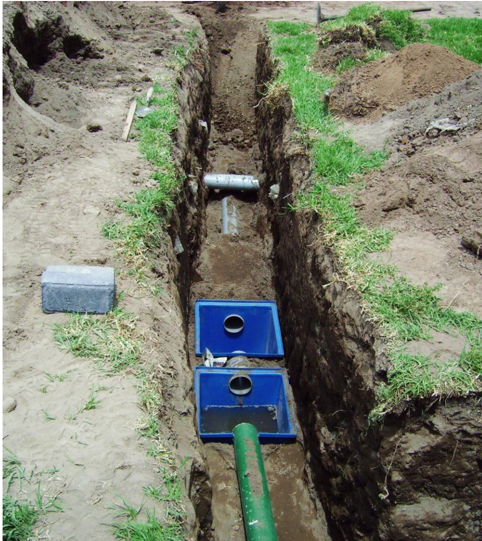
Foto 26: Sistema instalado y parcialmente recubierto
