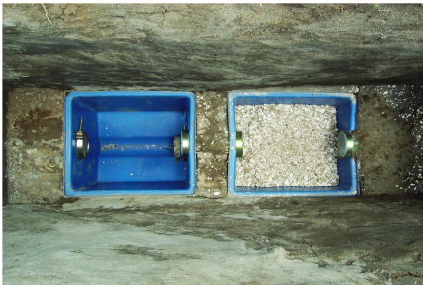
Foto 32: Capa de 12 cm de cascajo en el primer tanque.
