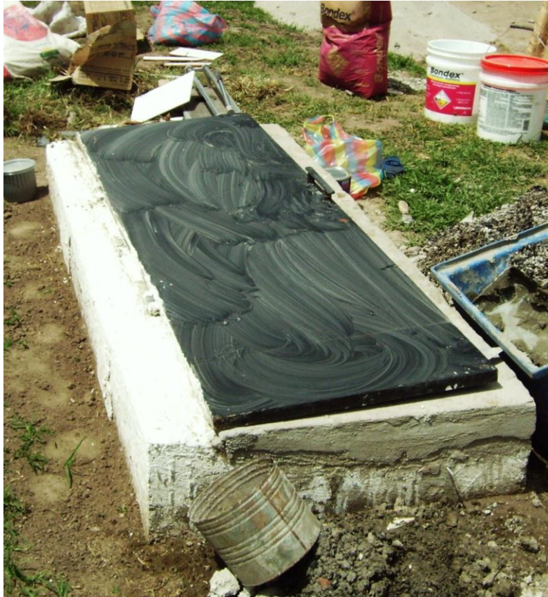
Foto 36: Bordillo y tapa metálica sobre el sistema filtrante.
