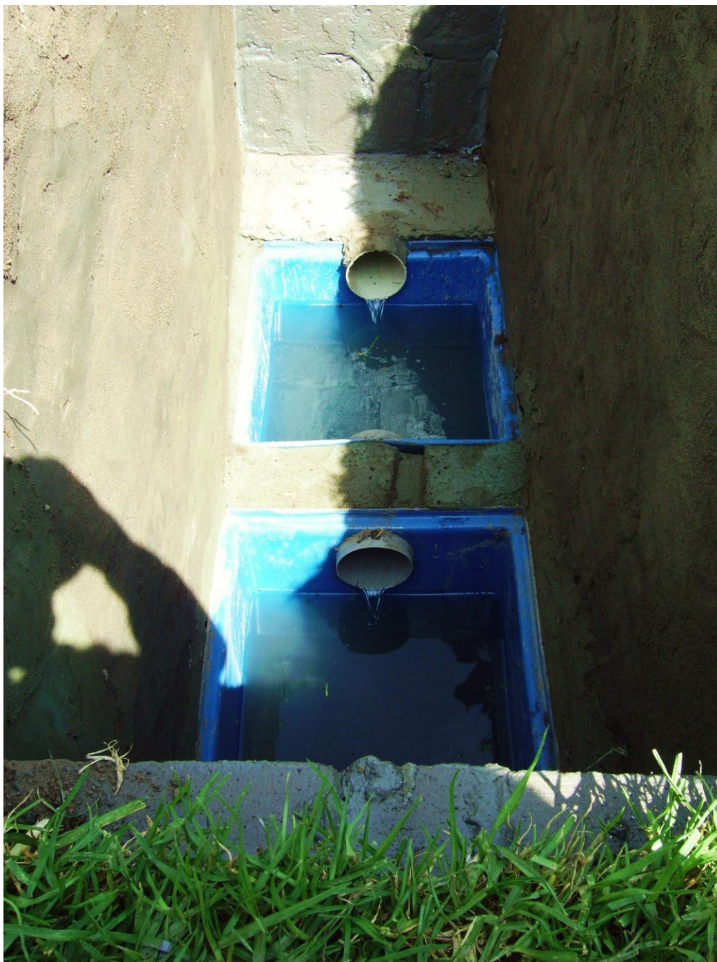
Foto 28: Prueba de funcionamiento
