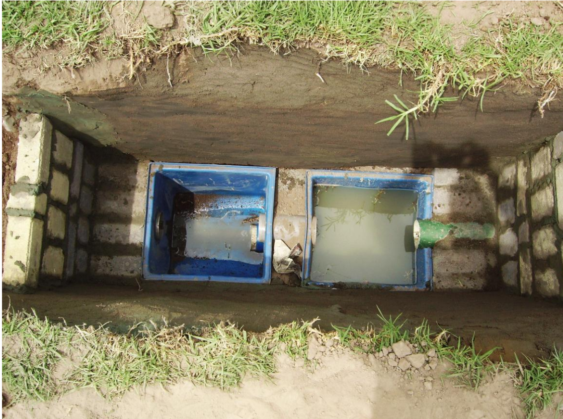
Foto 27: Construcción de paredes y enlucido de bordes
