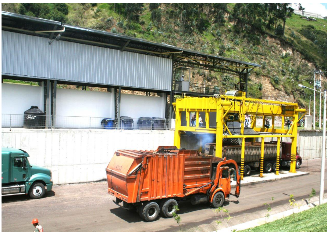
Fotografía: Estación de Transferencia de Zámbriza.
