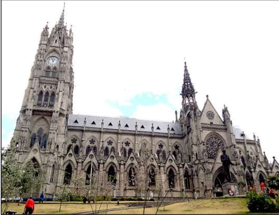
Figura 3, Fachada oriental Basílica del Voto Nacional. Tomada por el autor de la Tesis.
