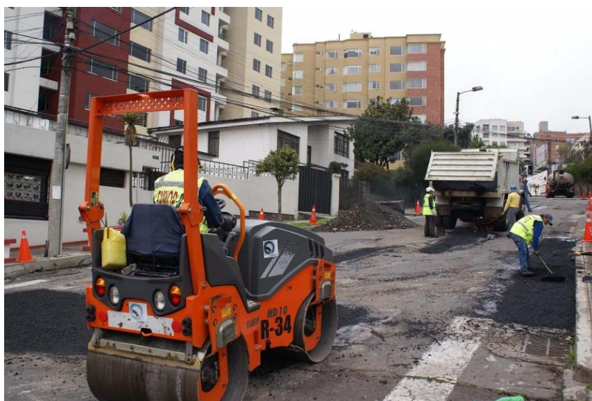
Gráfico 1.4 Reparación de la infraestructura vial.
