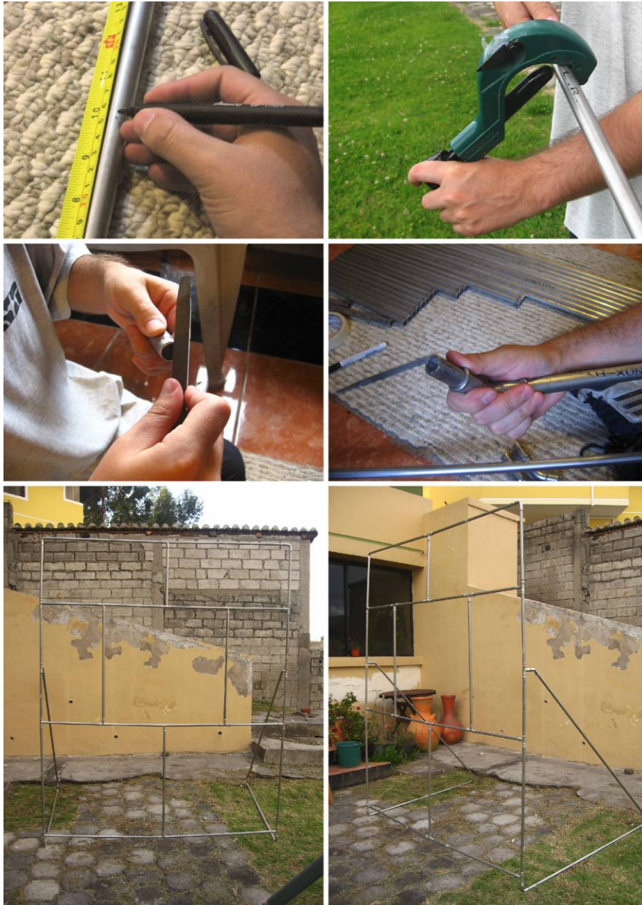
Arriba Izquierda: Medición de los tubos. Arriba Derecha: Corte de los tubos mediante cortadora manual para tubos de acero. Medio Izquierda: Lima de los bordes para que entre en la unión sin dificultad. Medio Derecha: Ensamble de piezas. Abajo Izquierda: Prototipo armado; vista frontal. Abajo Derecha: Prototipo armado; Vista en isometría.
