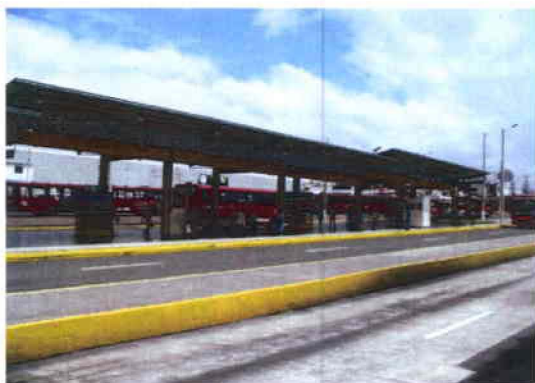
Completa Falta de señalética Andén de alimentadores (Estación Río Coca)
