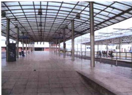
Falta de señalética para ingreso y salida. Andén de articulados (Estación La Ofelia)
