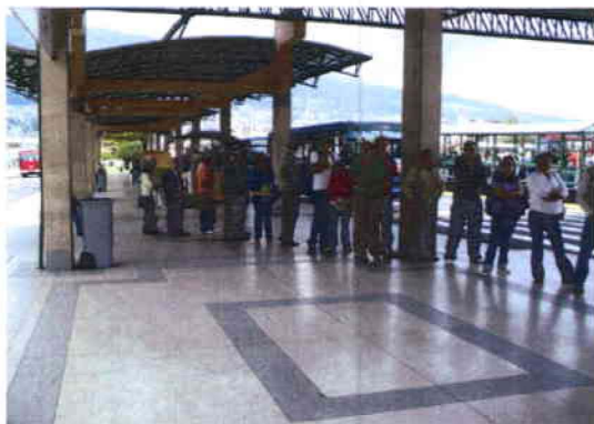
Falta de mobiliario y señalética de ingreso y salida de las unidades. Andén de alimentadores (Estación Río Coca)
