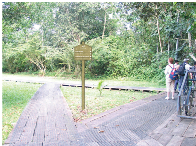
Fig 5.49 Montaje señal direccional
