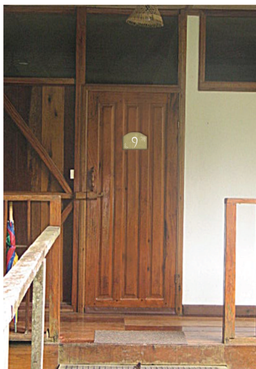
Fig 5.53 Montaje señal indicativa-numeración de cabañas
