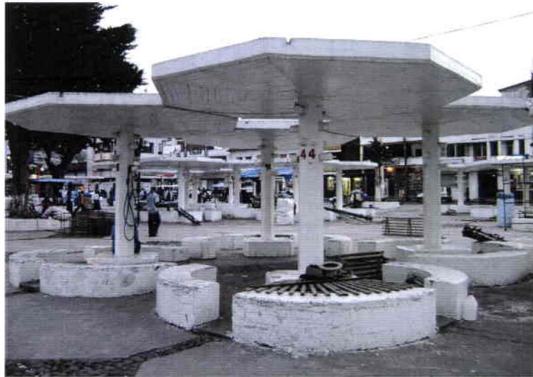
Arriba se muestra el mercado de Otavalo, las estructuras de hormigón sobre las cuales se arman los locales.
