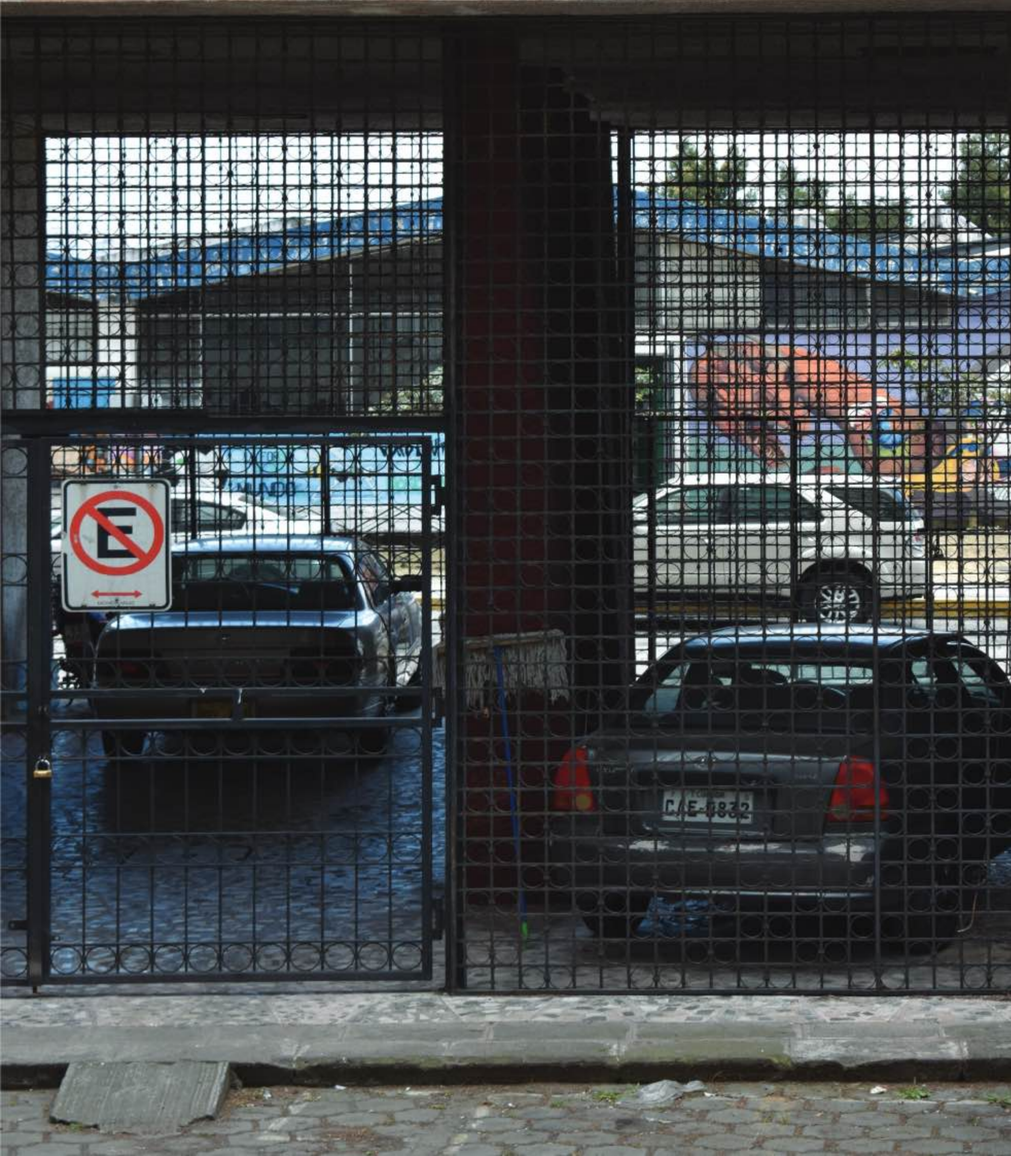
Fig. 41 Estado actual del edificio de la Antigua Residencia Universitaria - planta baja Fuente: Propia
