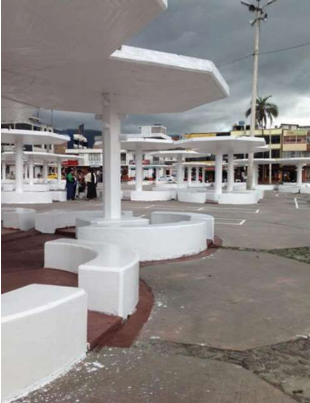
Figura 12. “Callambas” Estructuras Modulares en hormigón armado.
