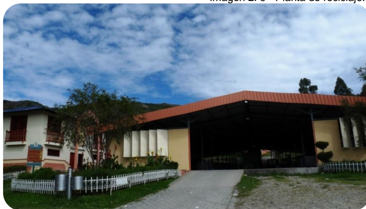
Imagen 2. 9 - Planta de reciclaje.
