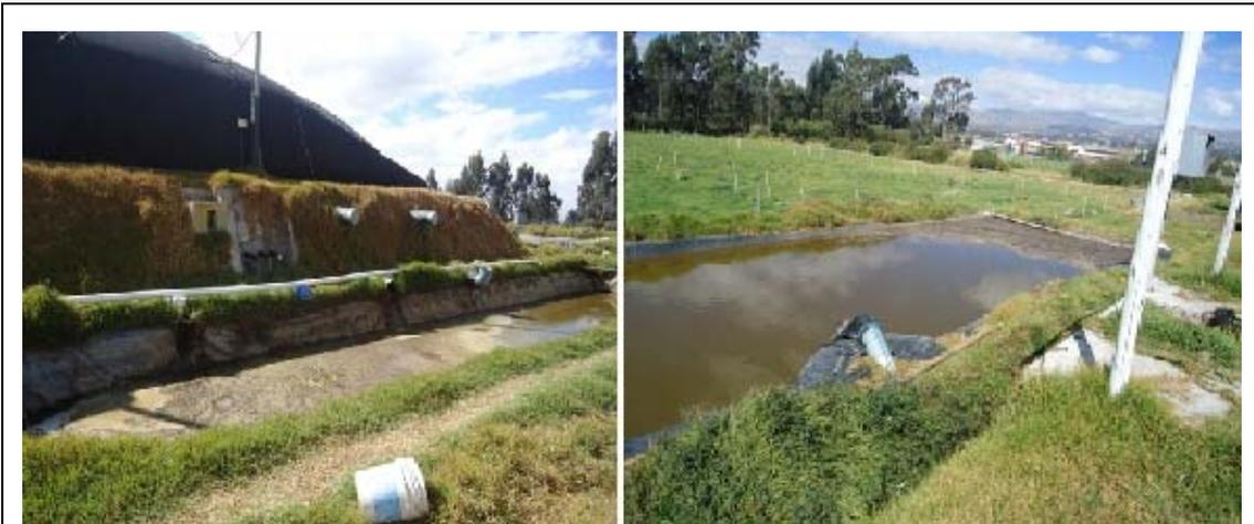
**Figura 29** Tanque de descarga/ Lecho de Secado de Lodos.
