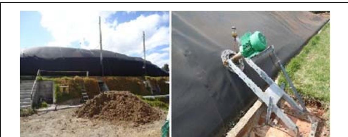
**Figura 27** Biodigester de Geo- membrana.
