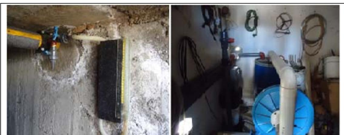
**Figura 30** Manómetro / Conexiones de válvulas y filtros para uso de Biogás en calderos.
