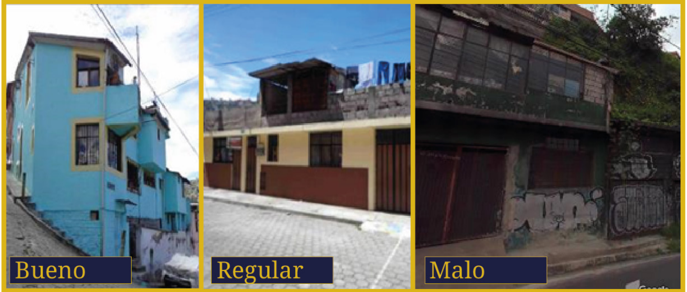
Fotografía 6. Estado de Edificaciones Fuente: IRM - (Google Maps, 2023)
