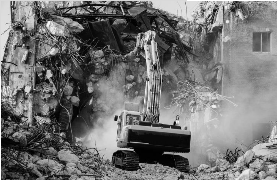
FIGURA 07. Imagen de demolición de edificio de hormigón. Fuente: (UMACON, s.f.)
