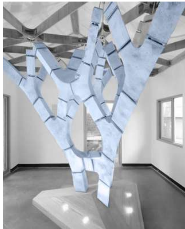
Figura 46. Imagen tomada de (Centre, 2017) Proyecto Mycotree, columna estructural a base de micelio en conjunto con la madera trabajando a compresión estructural.
