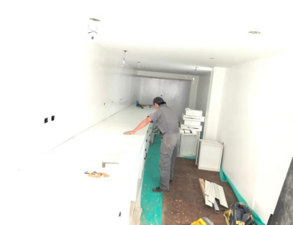
Fotografía 6. Área de laboratorio (construcción)
