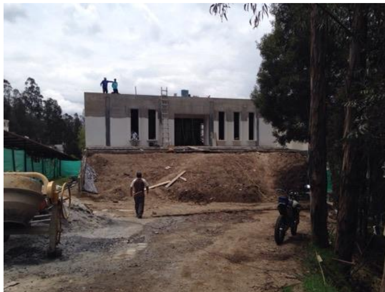
Figura 79. Acceso principal en construcción
