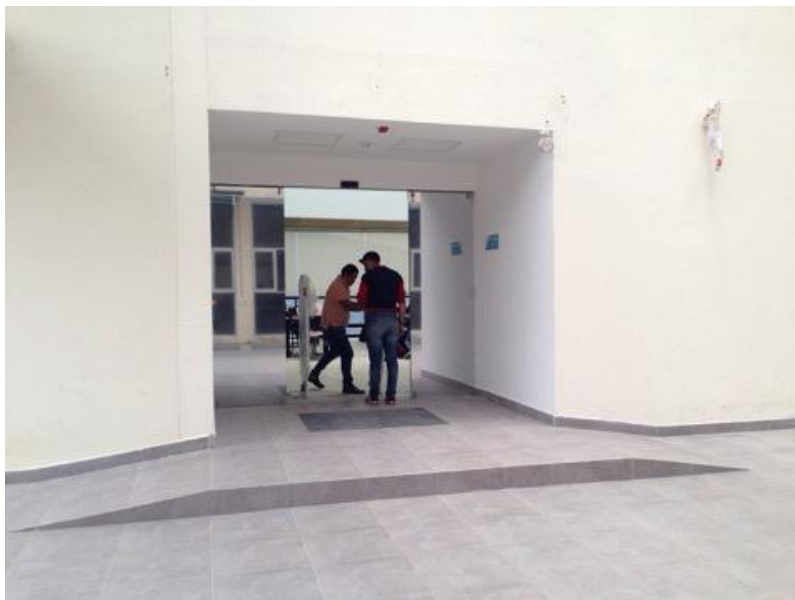
Figura 81. Entrada a biblioteca
