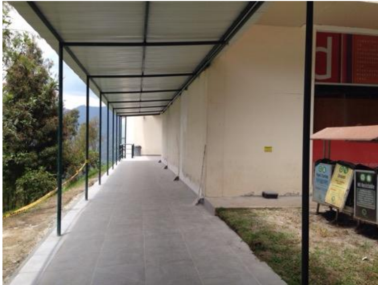
Figura 80. Acceso secundario hacia caminería
