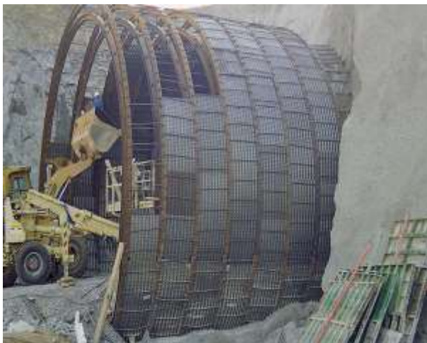
Figura 19: Montaje de chapa desplegada en túnel de Galicia
