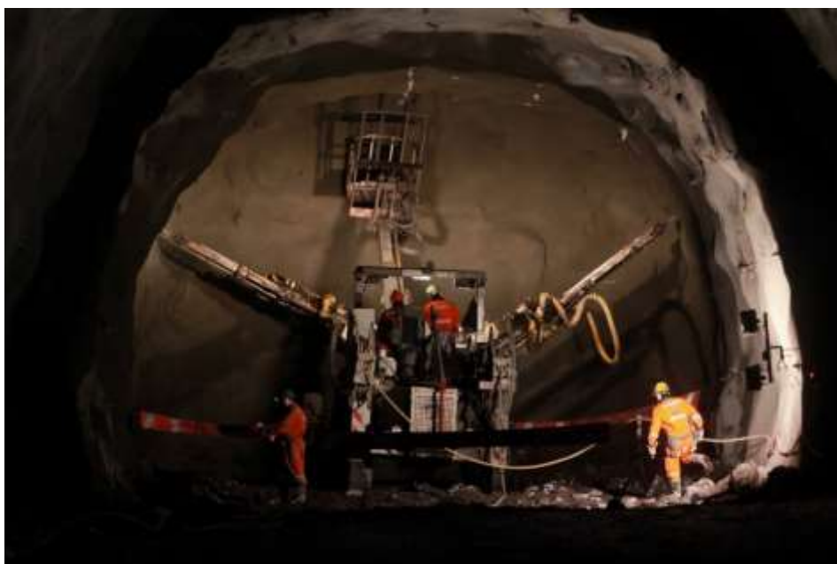
Figura 3: Perforaciones laterales de reconocimiento de suelos
