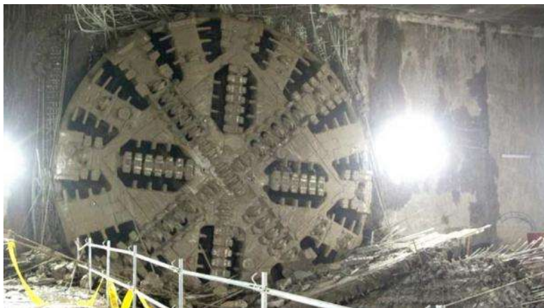
Figura 63: Cale de tuneladora en pantalla de pilotes
