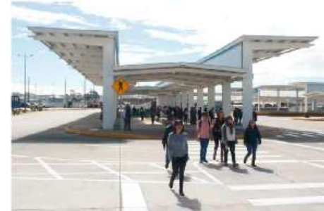
ESTACIÓN EL LABRADOR (ISAAC ALBÉNIZ Y AV. AMAZONAS)
