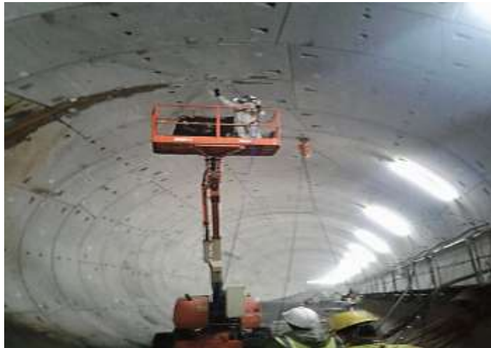
Figura 73: Técnica de Inyección por filtración
