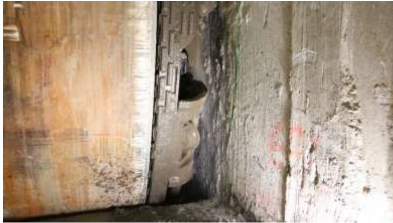
Figura 57: Emboquille de tuneladora en pantalla
