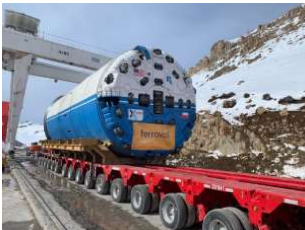
Figura 10: Tuneladora de escudo doble Proyecto los Cóndores
