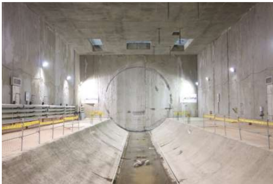
Figura 50: Detalle Cuna de Estación La Carolina
