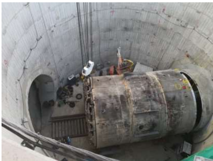
Figura 56: Tuneladora TBM La Guaragua en Pozo de extracción
