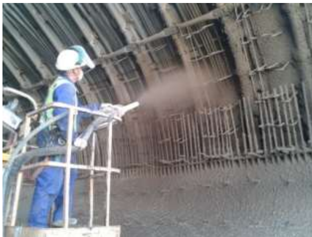
Figura 18: Proyección de Gunita sobre un axial del túnel
