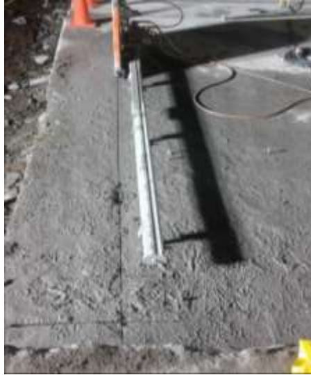
Figura 60: Corte guía de pantalla de pilotes
