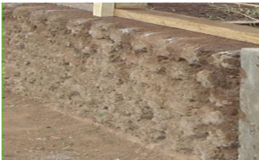
Figura 56 Casa con muro horizontal y enlucido de cemento-arena, 1:4.
