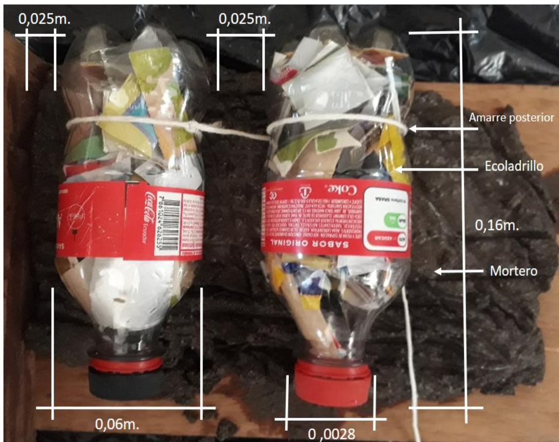
Figura 25 Amarre posterior botellas vista superior
