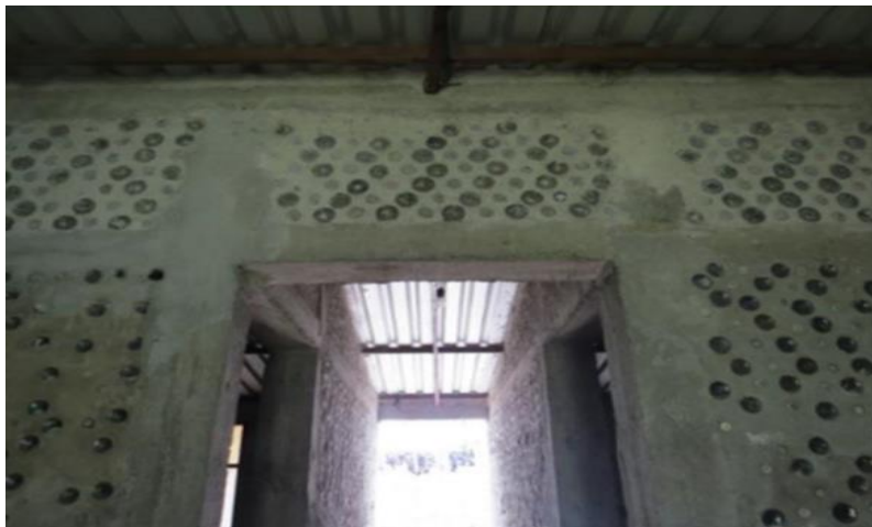
Figura 54 Casa con muro horizontal.
