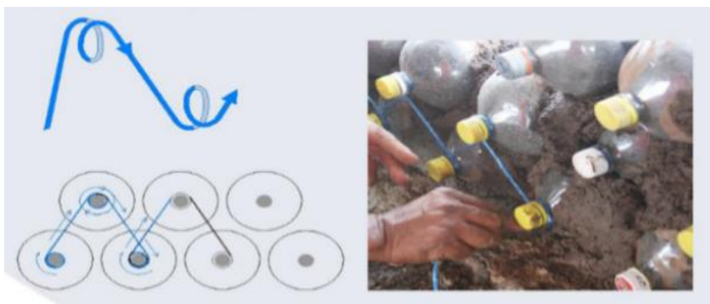
Figura 27 Sistema constructivo horizontal y amarres entre botellas
