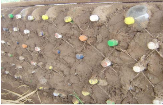
Figura 55 Casa con muro horizontal y enlucido de cemento-arena 1:4.
