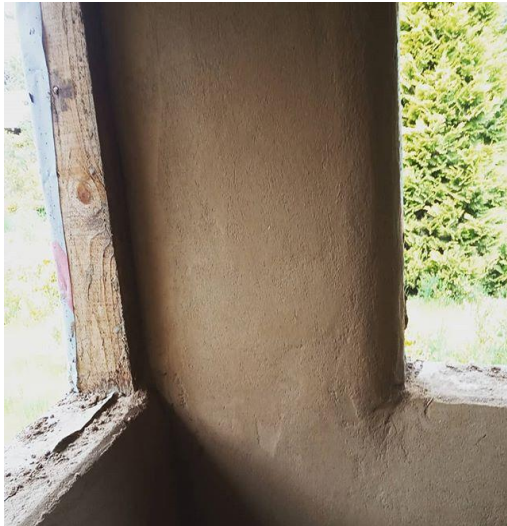
Figura 57 Casa con muro vertical y enlucido de común, 1:4.
