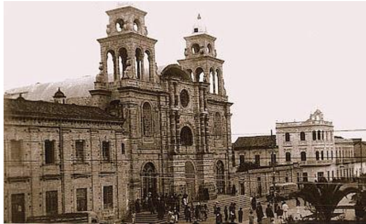
Figura 80. Foto antigua de la Basílica de la Merced.
