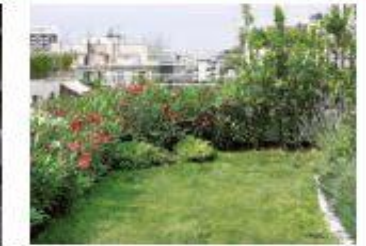
La tecnología nos permite un amplio abanico de posibilidades en la cubierta vegetal intensiva.
