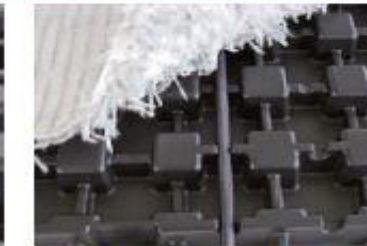
Tras la instalación, los flecos de la manta absorben el agua por capilaridad y humedecen el sustrato.
