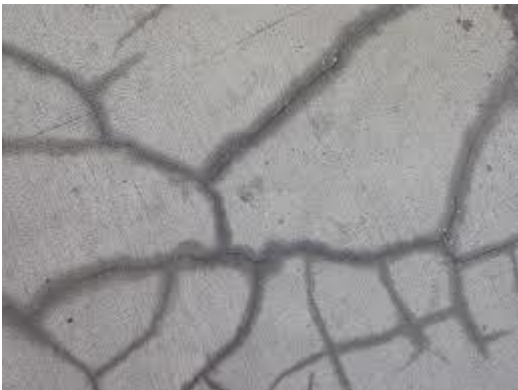
Figura 11. Retracción térmica del hormigón Tomada de Argos 360
