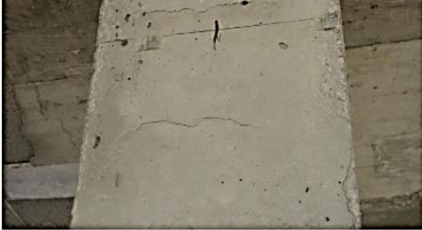
Figura 7. Fisuración en zona de estribos en pilar Tomada de (Santillana, 2012)
