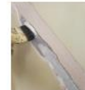
Fotografía 7: Sellado de fisura Fuente: Autoría propia
