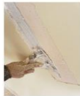
Fotografía 8 Aplicación de Masilla elastomérica Fuente: Autoría propia
