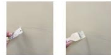
Fotografía 6: Limpieza de Fisura con herramientas (brocha-espátula)
