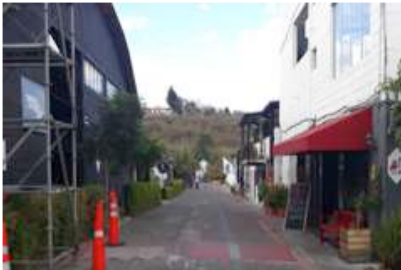
Figura 50. Entrada principal al Bloque C
