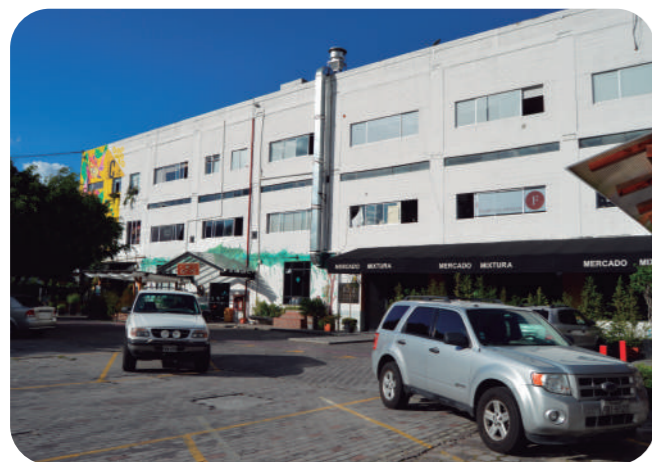
BLOQUE C- VISTA LATERAL EXTERIOR
