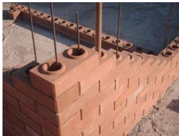
Figura 16. Pared de ladrillo ecológico
