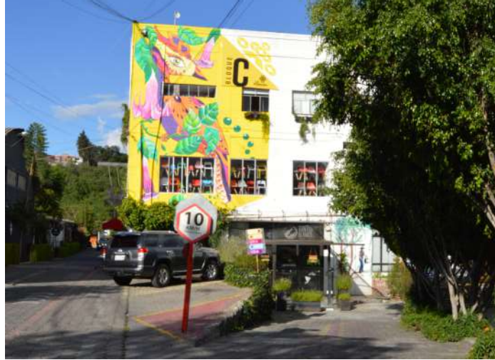
Figura 45. Fachada Bloque C
